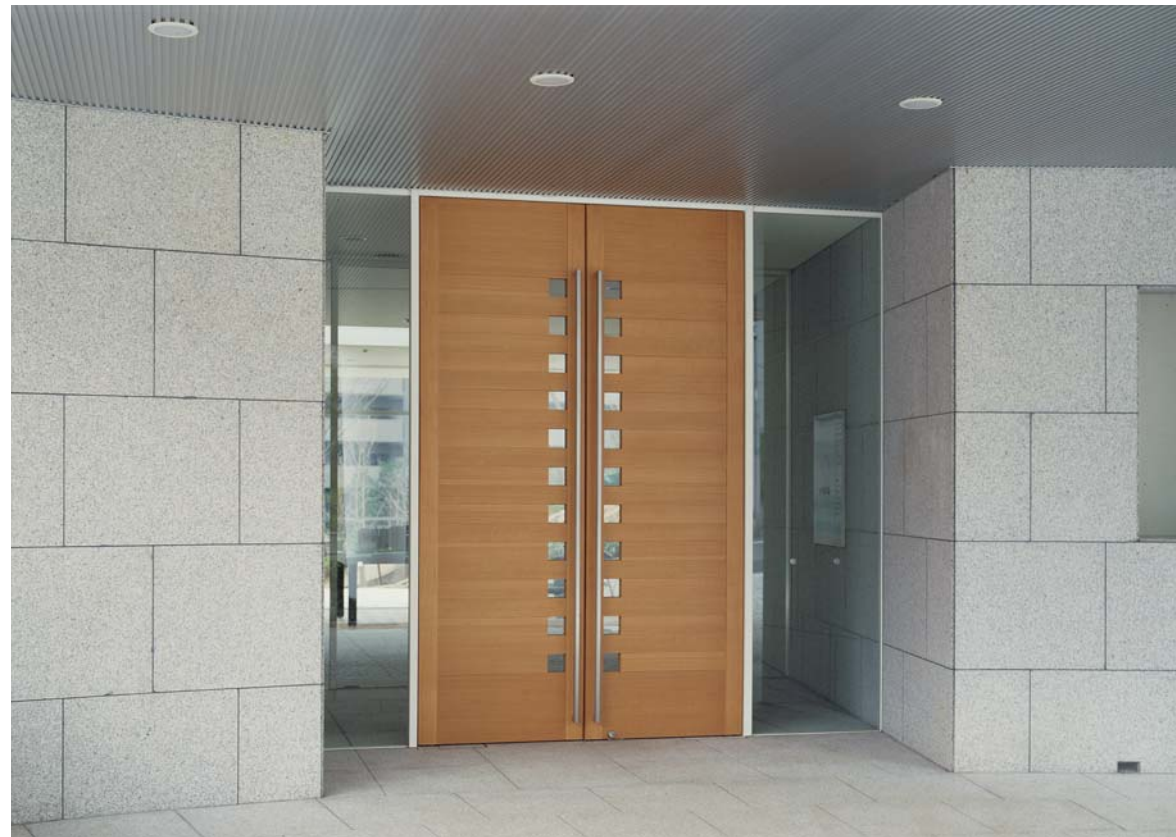
施工例 東京都 大田区(突板ウレタン塗装仕上げ)
